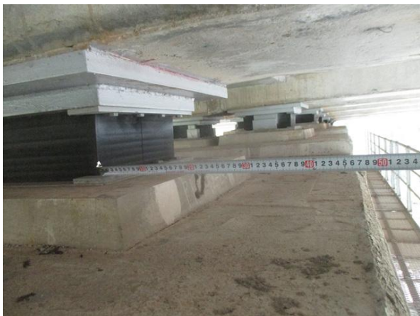
교량받침 제원 측정
