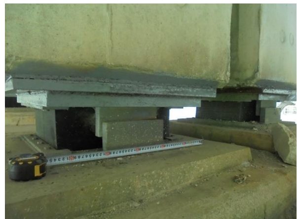
교량받침 이동량 측정
