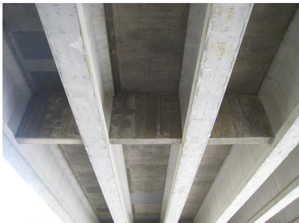
거더 및 바닥판하면 전경
